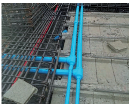
Tuberías empotradas en losa.
